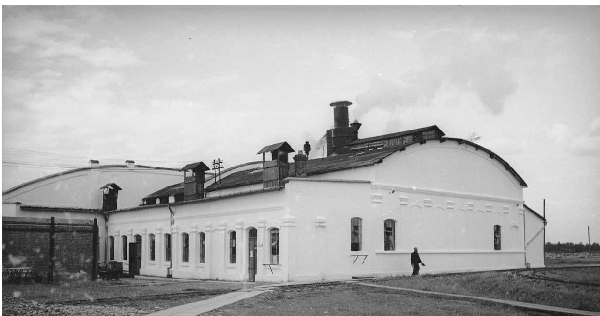
Парова лісопилка Дж. Ф. Glesinger - будівля пилорами. 1938 рік. 40
